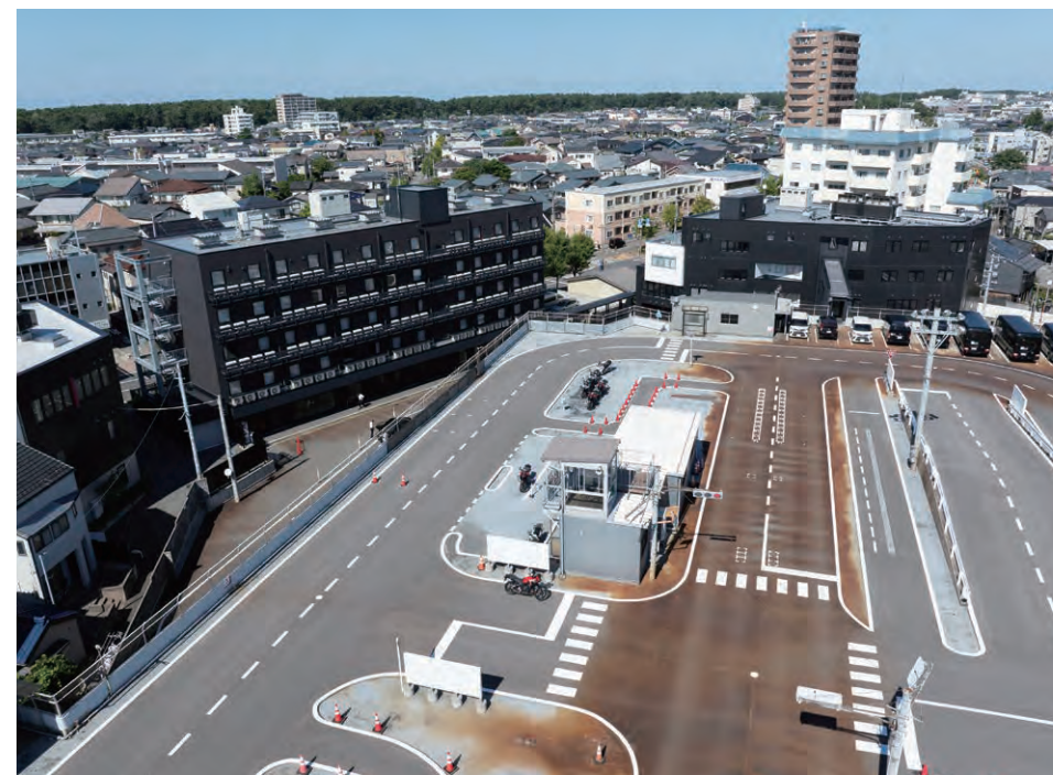
令和7年の2階コースと校舎、合宿寮、食堂の全景。
